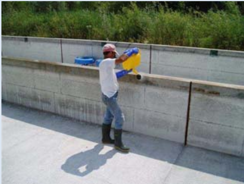
Trockene, gereinigte Becken
